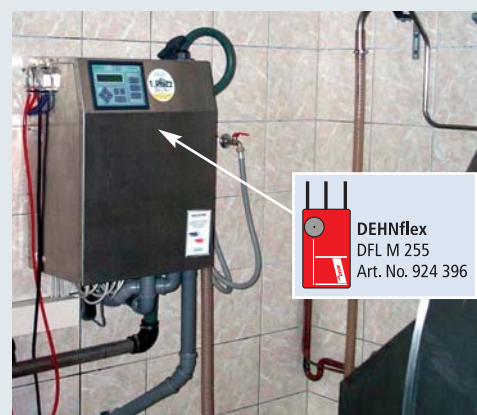
Instalación de ventilación y lavado
