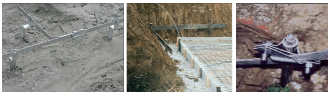
Figura 6: Instalación de puesta a tierra.
