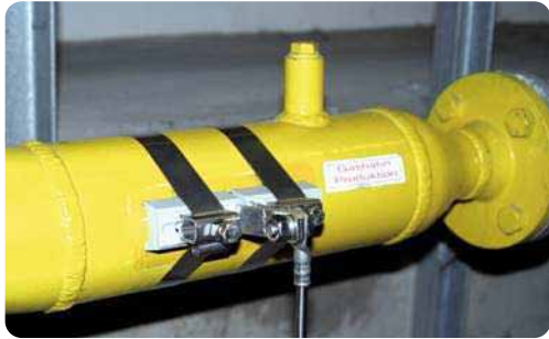
Abrazaderas para contactos eléctricos seguros con las tuberías en áreas explosivas para la implementación de la compensación de potencial según la norma IEC 62305-3 EN 62305 (VDE 0185-305-3)
