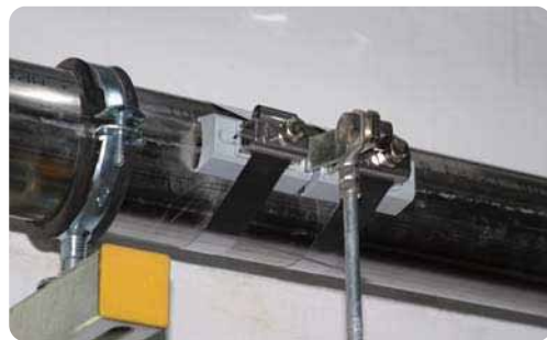
Abrazadera para áreas con riesgo de explosión conectado a un tubo de acero inoxidable (StSt)
