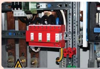
Qué certificados de prueba puede acreditar, si está clasificado bajo IEC 61643-1, si posee contactos para señalización a distancia, señalización de estado, si es modular enchufable, si es para montaje en riel, si tiene que descablearlo para pruebas de aislamiento. El DPS deberá estar dimensionado para la tensión nominal es decir la medida entre fase y neutro.
